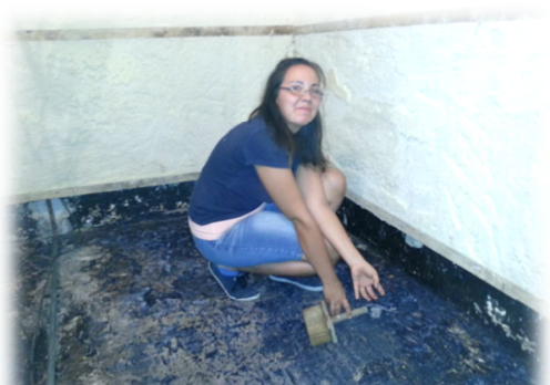
Daniela hjelper til med reparasjonen av fryserommet
